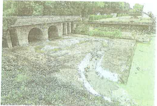
Une rampe en enrochement permet de supprimer l'effet de marche et de favoriser la migration piscicole.
