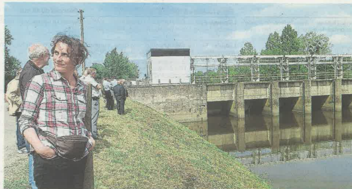
Lors de l'inauguration, mardi, en attendant l'ouverture des six vannes indépendantes, que deux centrales hydrauliques permettent de lever en 90 secondes (pour prélever l'eau douce en Loire l'été) et refermer en 60 secondes, pour empêcher les remontées d'eau salée.
