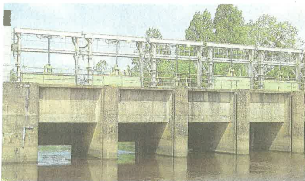
La Perçée de Buzay et ses vannes à ouvertures automatiques et vanelles piscicoles.
