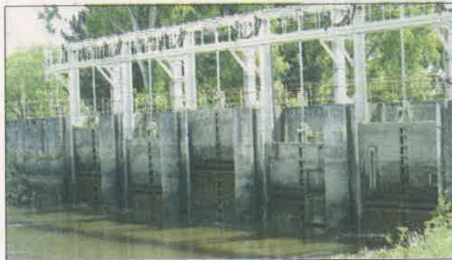
La restauration intègre la transparence piscicole, la souplesse hydraulique des 6 vannes et le souhait d'une intégration paysagère
