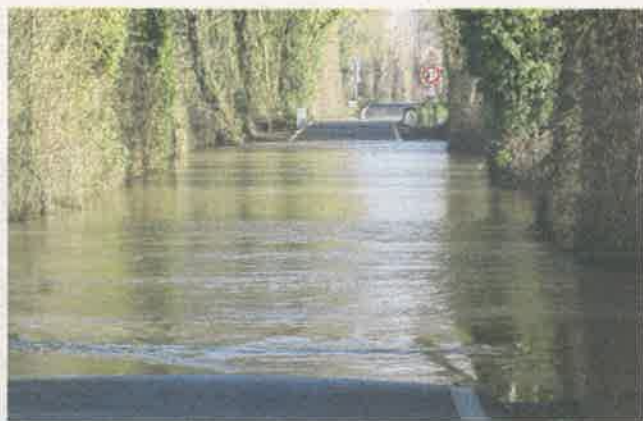
La route de Cahouët dont on ne voit plus que les ponts.
