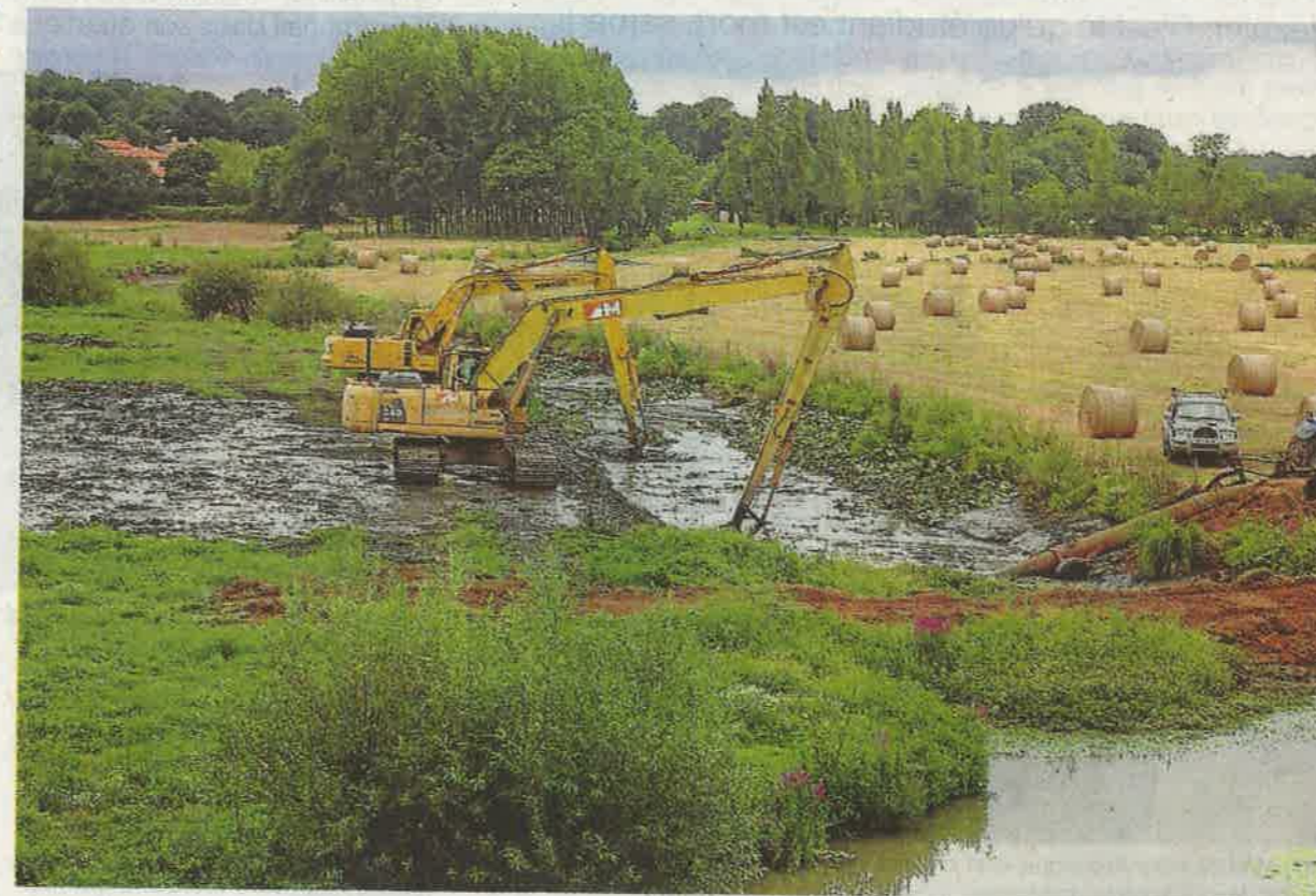
Il a fallu deux pelleteuses, dont une de 30 tonnes, avec un grand bras, afin d'atteindre l'autre extrémité de la berge.
