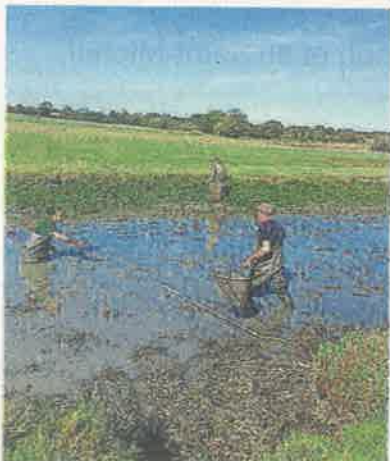
Pendant les travaux, 10 personnes ont assuré une pêche de sauvegarde.
