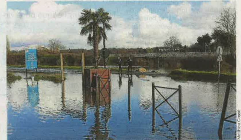
Mercredi après-midi, le canal de Haute-Perche est sorti de son lit, inondant une partie de la chaussée et du parking.
