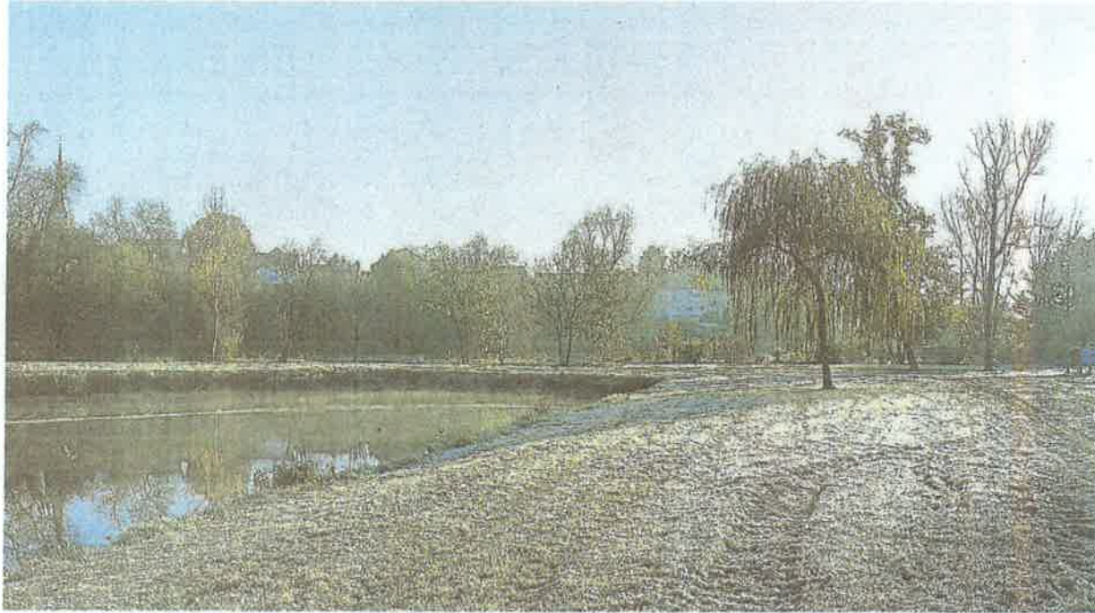
Les travaux de réaménagement vont bon train.
